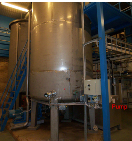
Bild 1: Pumpar, strypventiler och buffertankar som ersatts av varvtalsreglerad pump (röd text) i ljusisolerad låda. Foto: Jan Fors.
