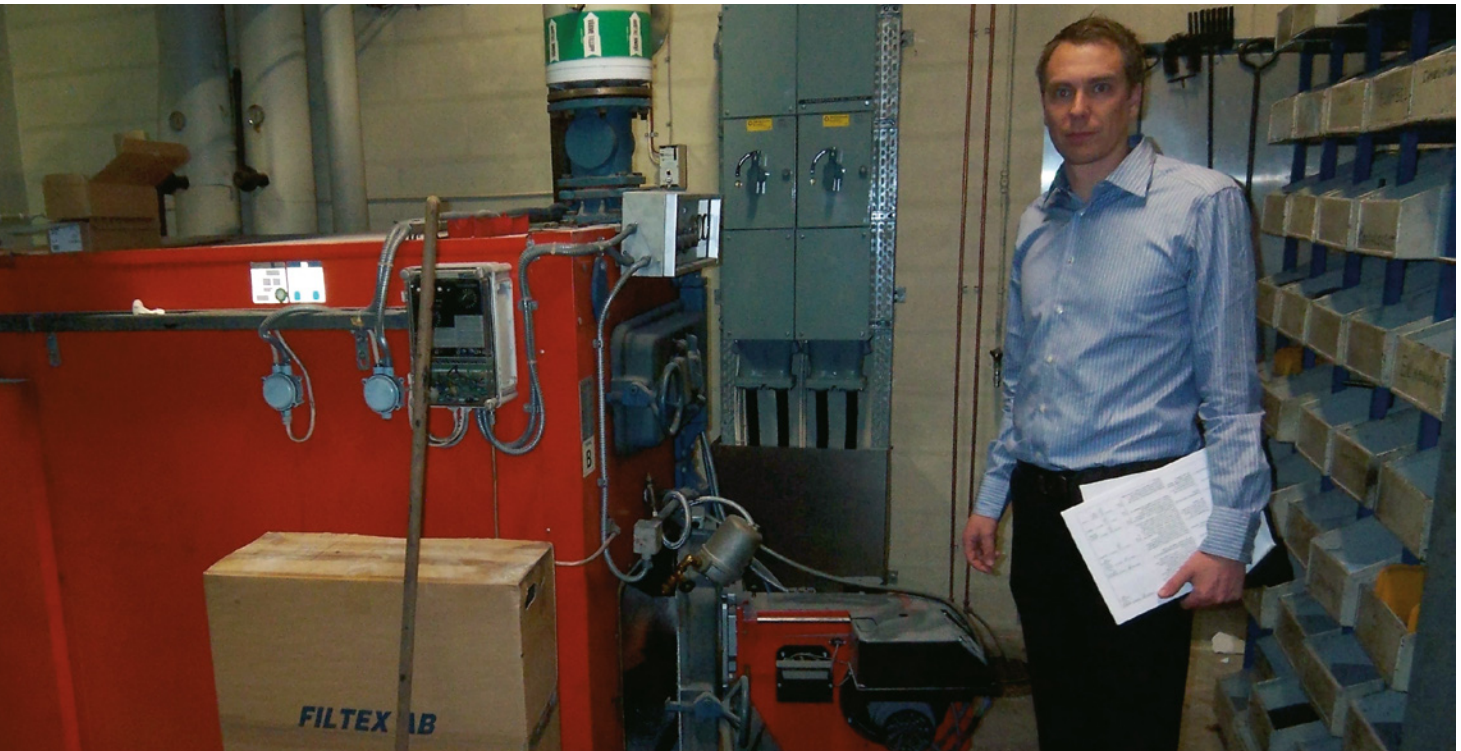
Bild 8: Avställda oljepannan. Foto: Jan Fors.
